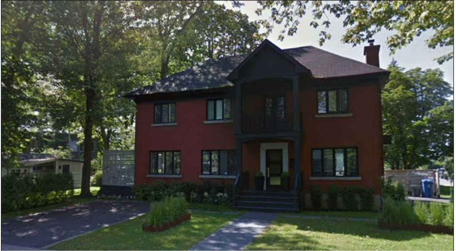
Photo du bâtiment existant
