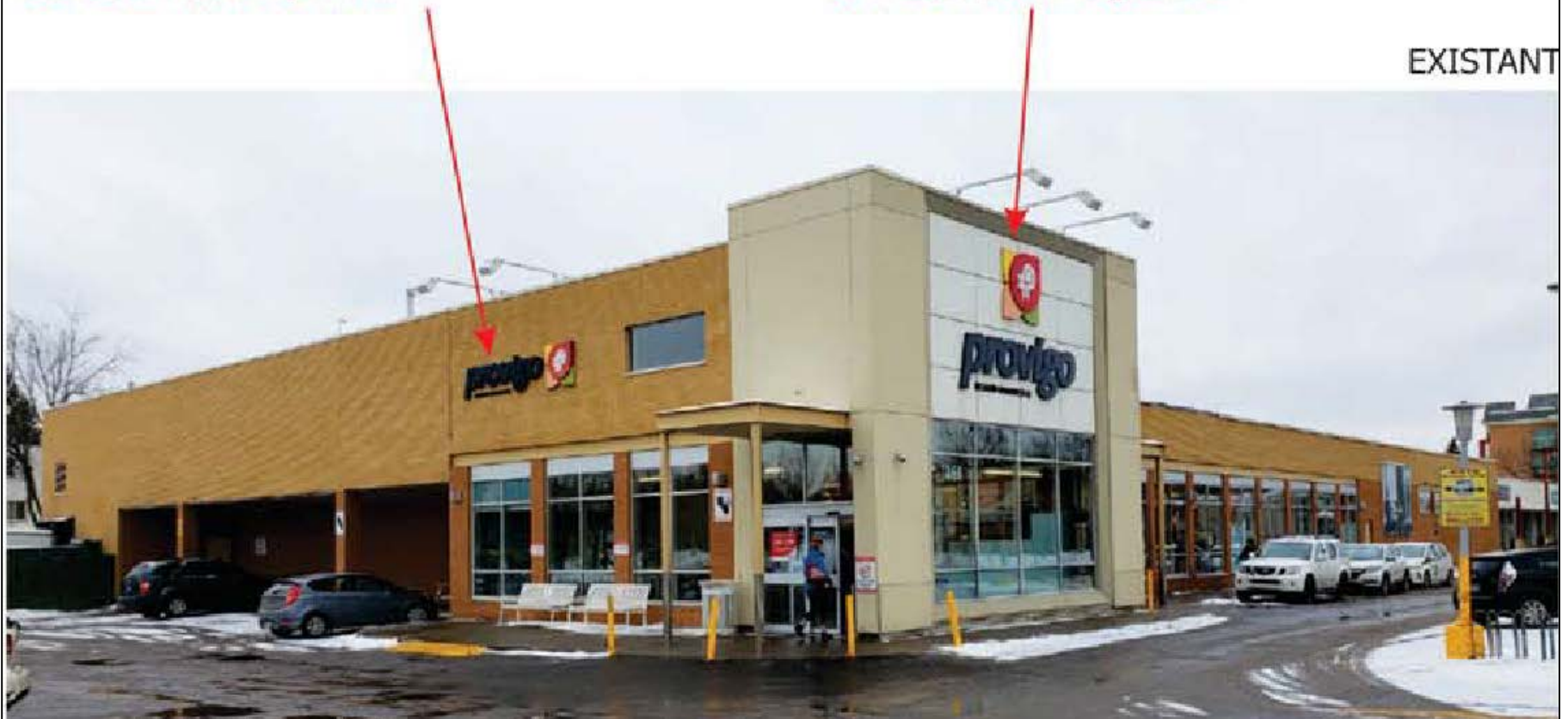
Photo du bâtiment existant
