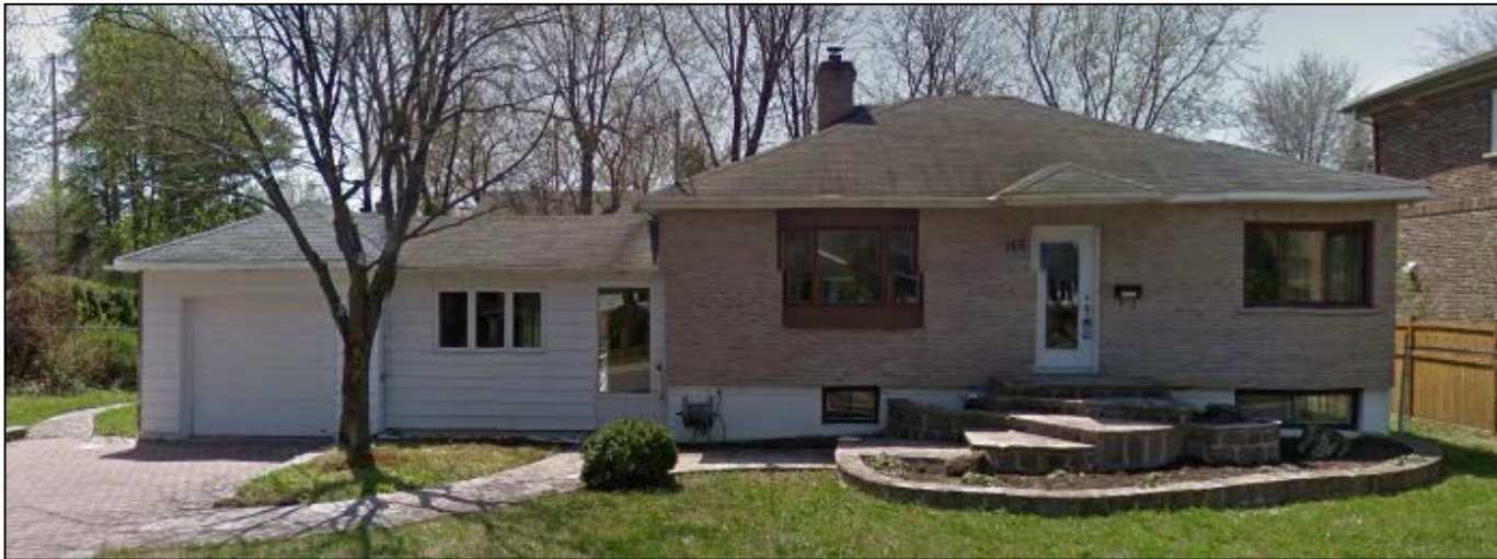
Photo du bâtiment existant
