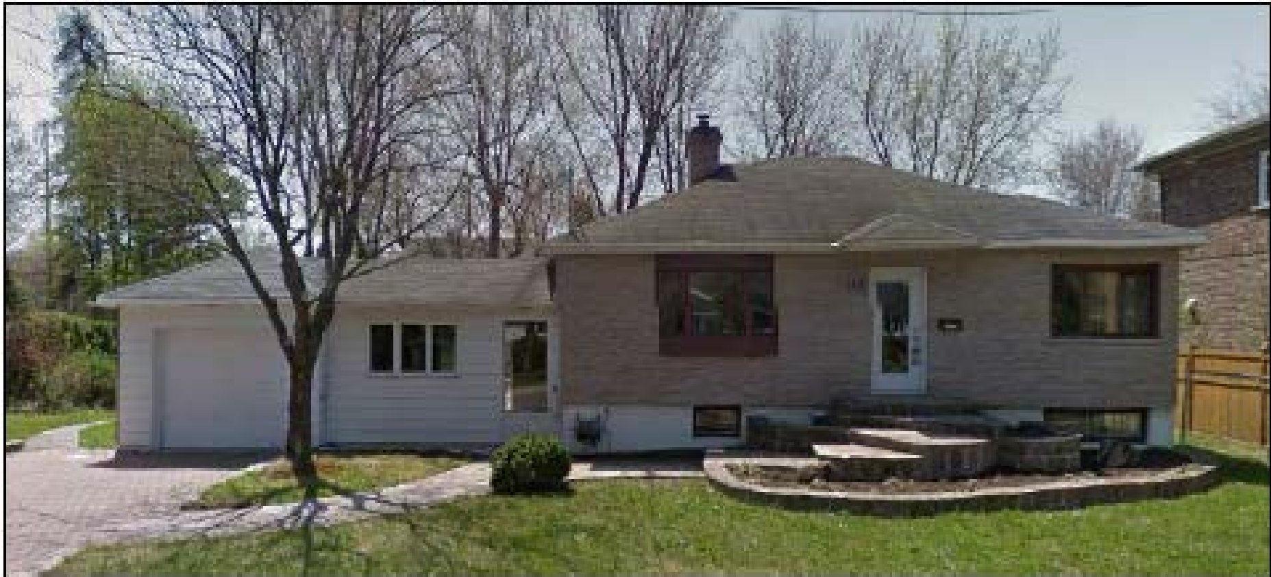
Photo du bâtiment existant
