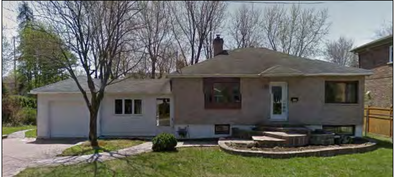
Photo du bâtiment existant
