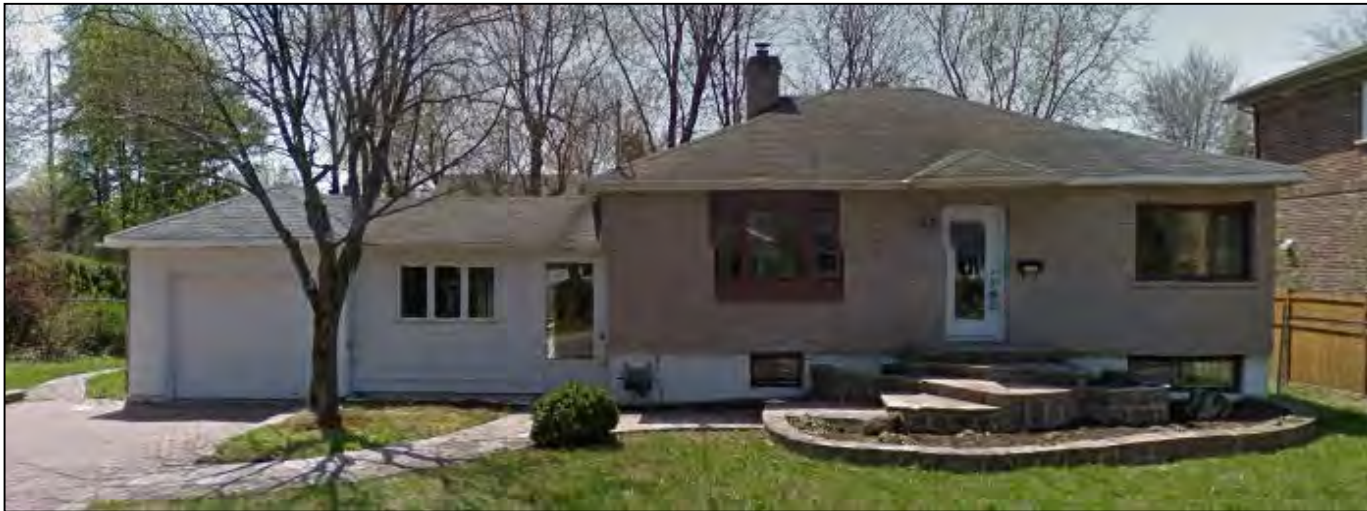
Photo du bâtiment existant
