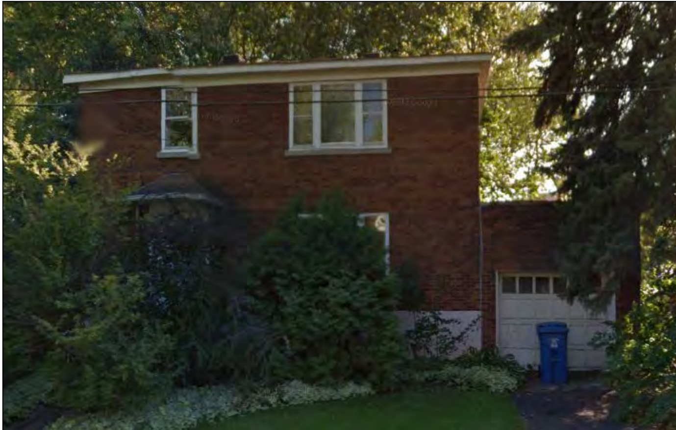
Photo du bâtiment existant (avenue Pine)
