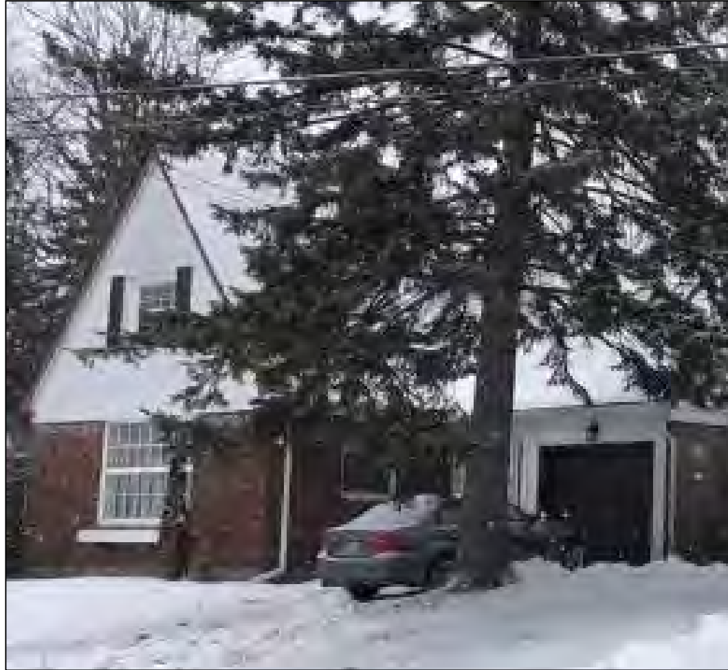
Photo du bâtiment existant
