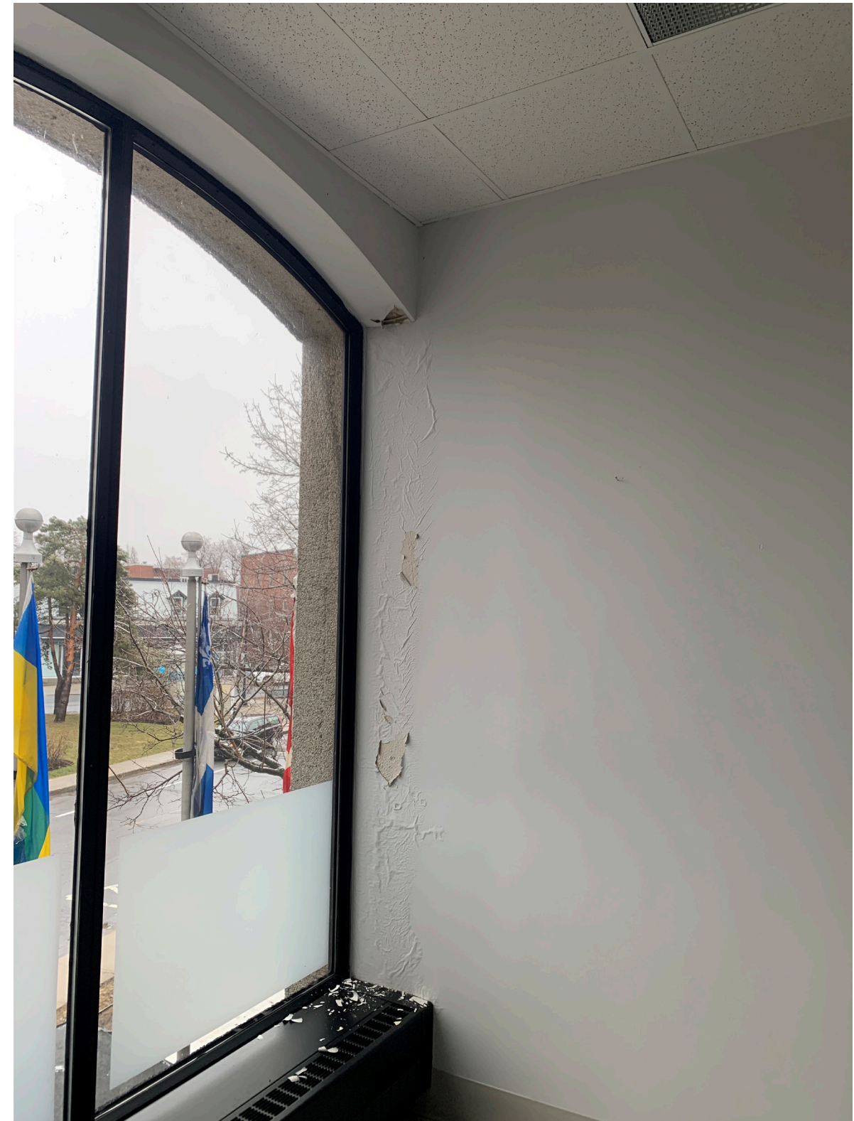
Détérioration des murs et plafonds causée par les infiltrations d'eau
