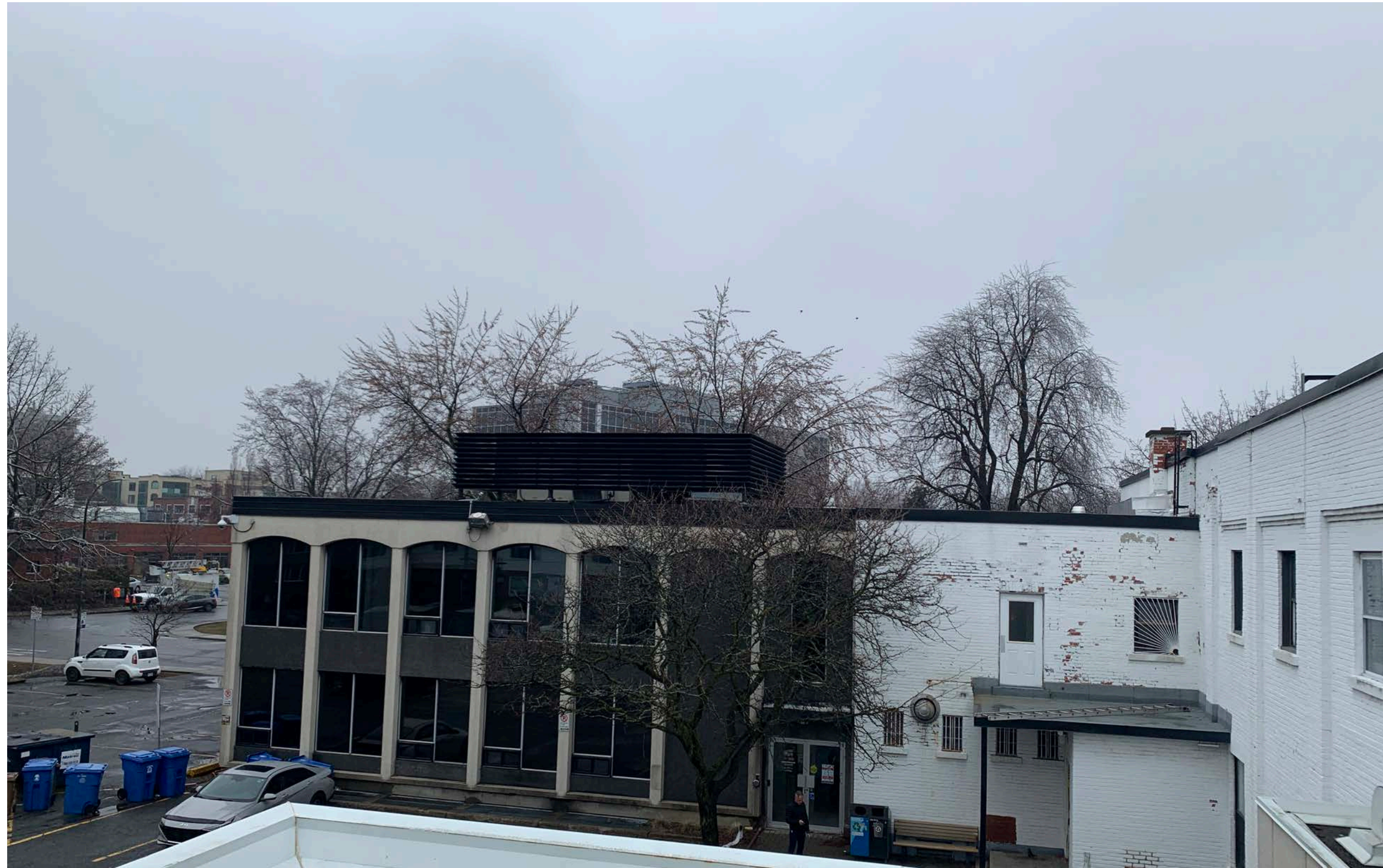
Dégradation de la brique de la section originale
