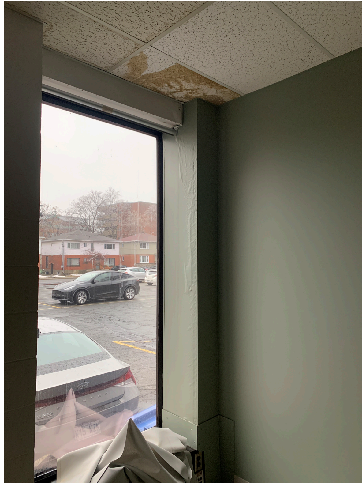
Détérioration des murs et plafonds causée par les infiltrations d'eau
