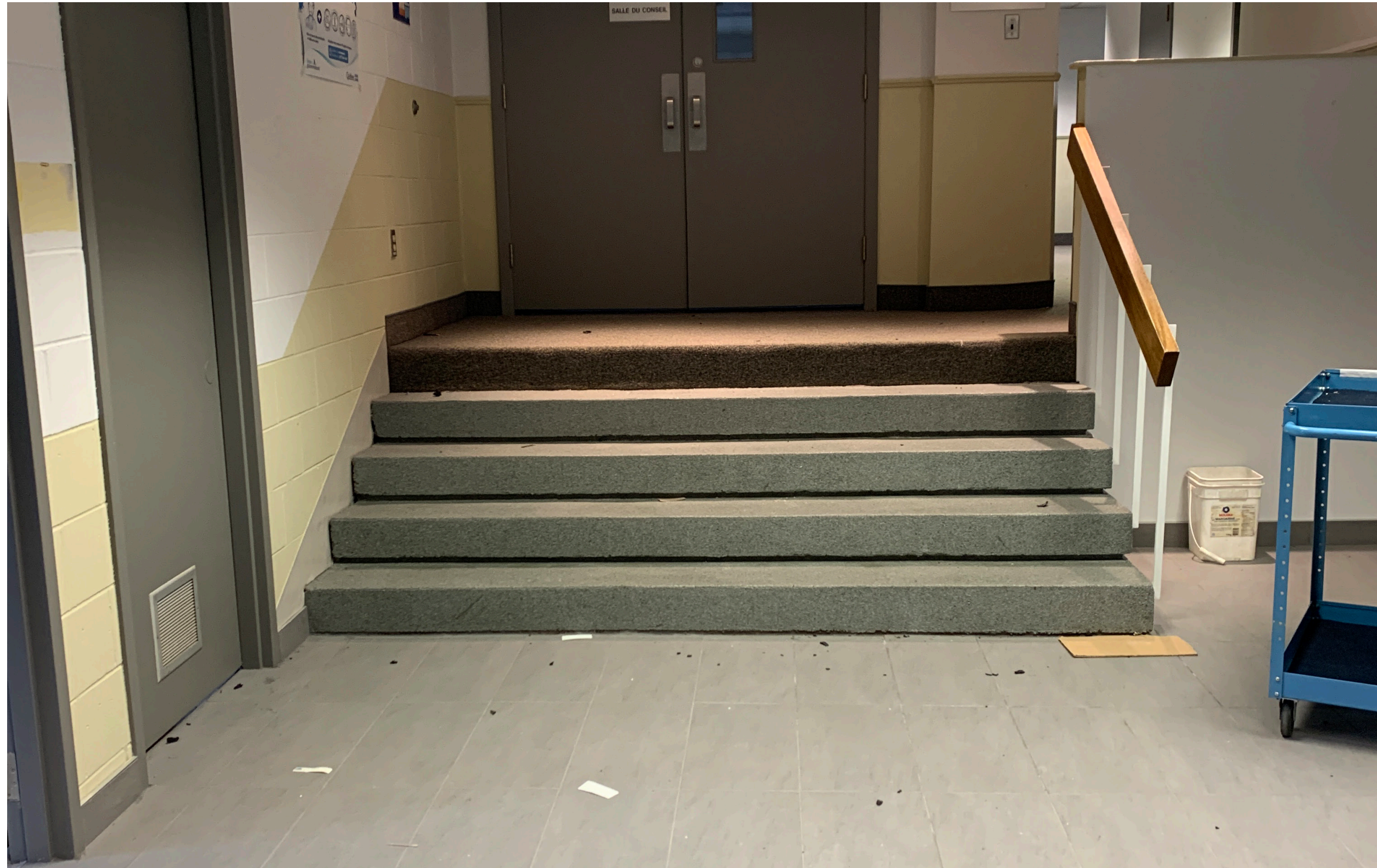
Différence de niveaux sur un même étage
