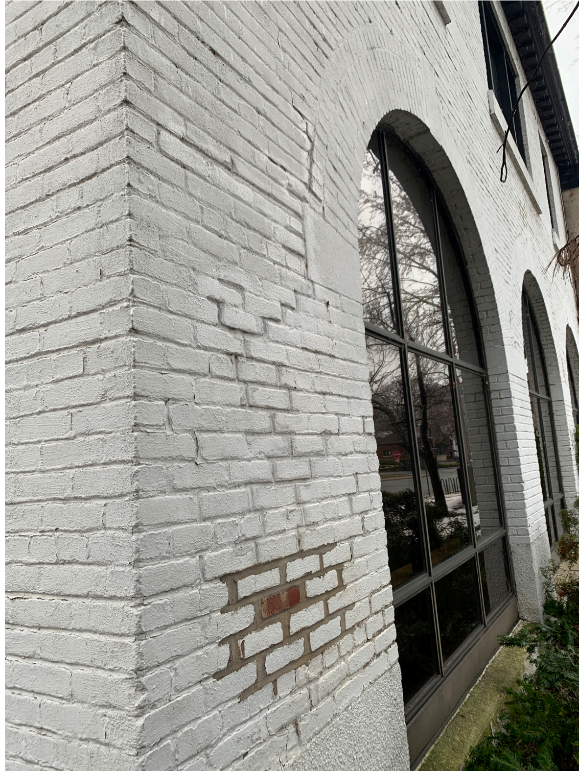
Dégradation de la brique de la section originale
