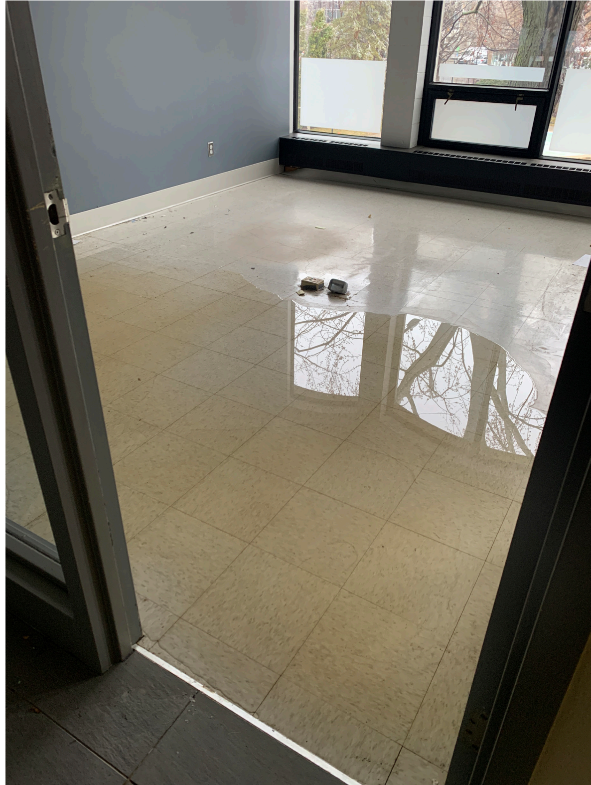
Accumulation d'eau au sol
