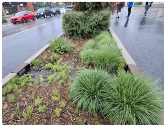
Noues et fosses drainantes
