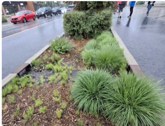
Noues et fosses drainantes
