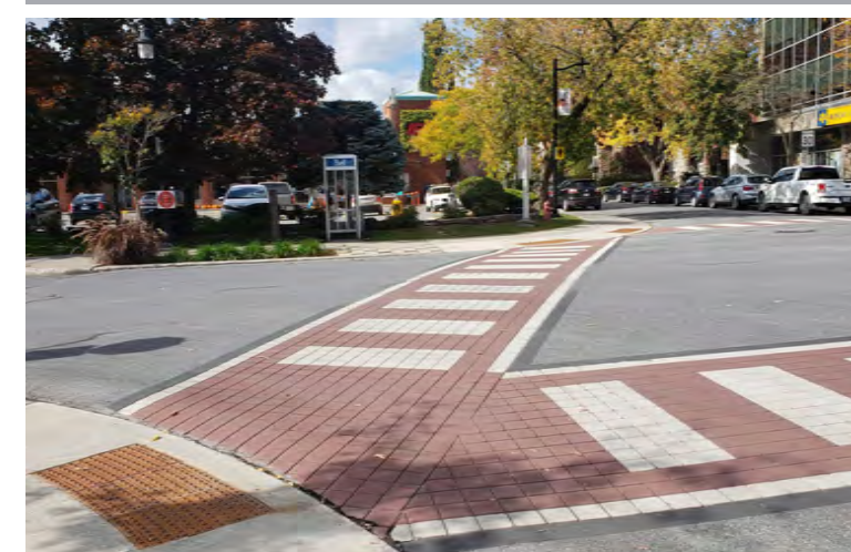
Traverses piétonnes sécurisées
