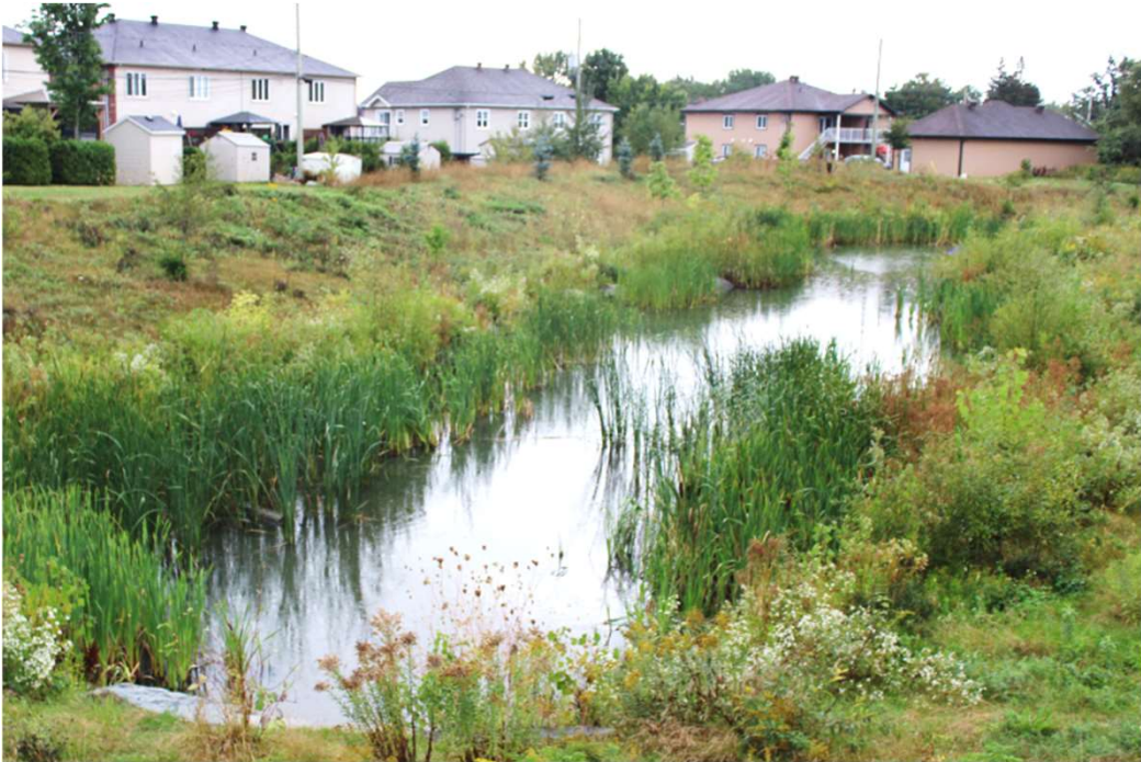
Bassin de rétention • Source: Avizo et Wikimedia Commons
