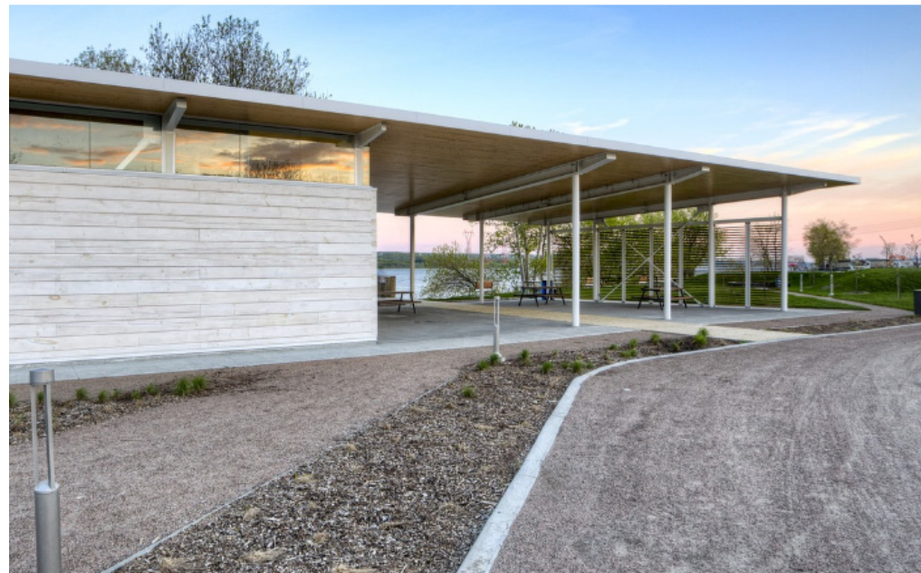
PLATELAGE DE CLT ET STRUCTURE EN ACIER Parc riverain Espace Fillion à l'Ange Gardien (Coarchitecture/François Courville / LGT, Québec)
