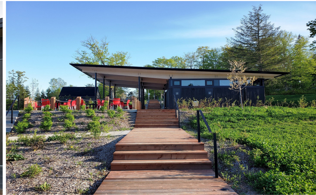
GRANDE TOITURE EN LAMELLÉES-COLLÉES Chalet et pôle nautique Duchesnay (Bourgeois-Lechasseur architectes/Coarchitecture, Québec)
