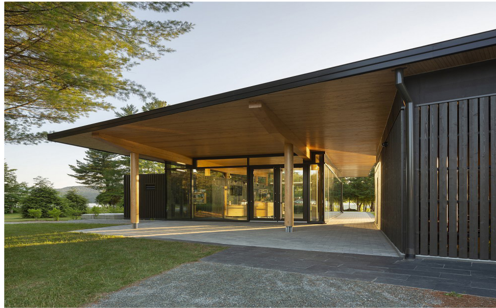
TOITURE MINCE ET MUR-RIDEAU Centre de service Opeongo du Parc national du Mont Orford (Anne Carrier, Québec)
