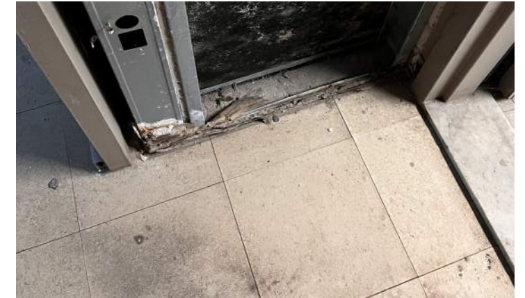
023 Local des pompiers
