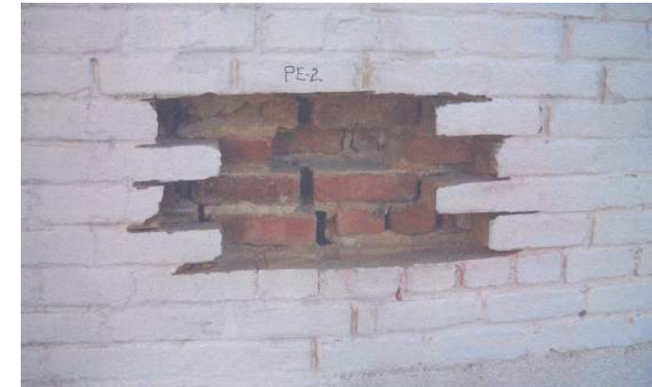
Rapport sommaire des parements de maçonnerie, non daté, photo no 6. Percée exploratoire no 2 (Fissure coin sud-est) p. 4
