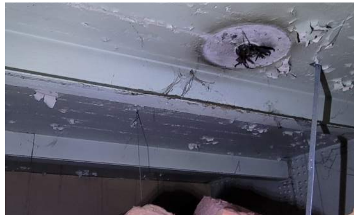
Entreplafond du rez-de-chaussée
