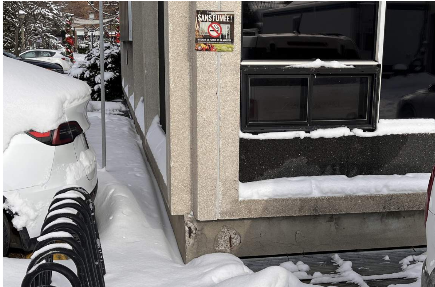
Coin sud-ouest donnant sur le stationnement
