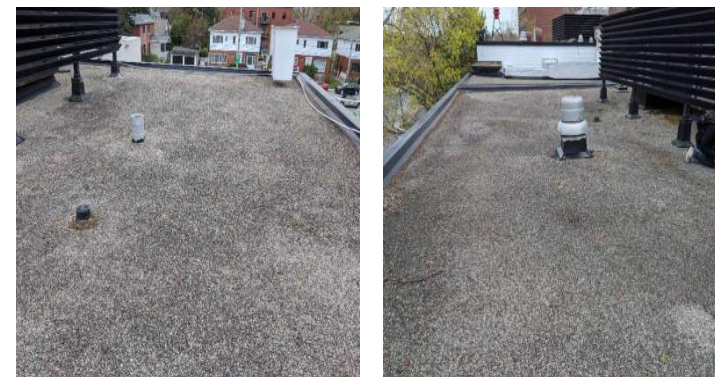
Mise à jour du PDMA 2020 de l'hôtel de Ville, Saint-Lambert, TBMaestro, Fiches d'interventions, p.11
