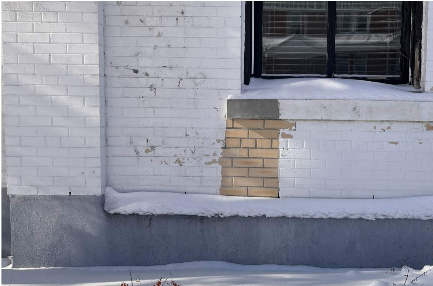
Mur est, rue Aberdeen
