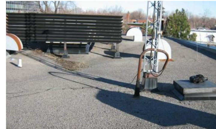
Roof Condition Assessment Report, Ville de St-Lambert, 55 Argyle, Premier Levaque Inc, décembre 2010, p 12
