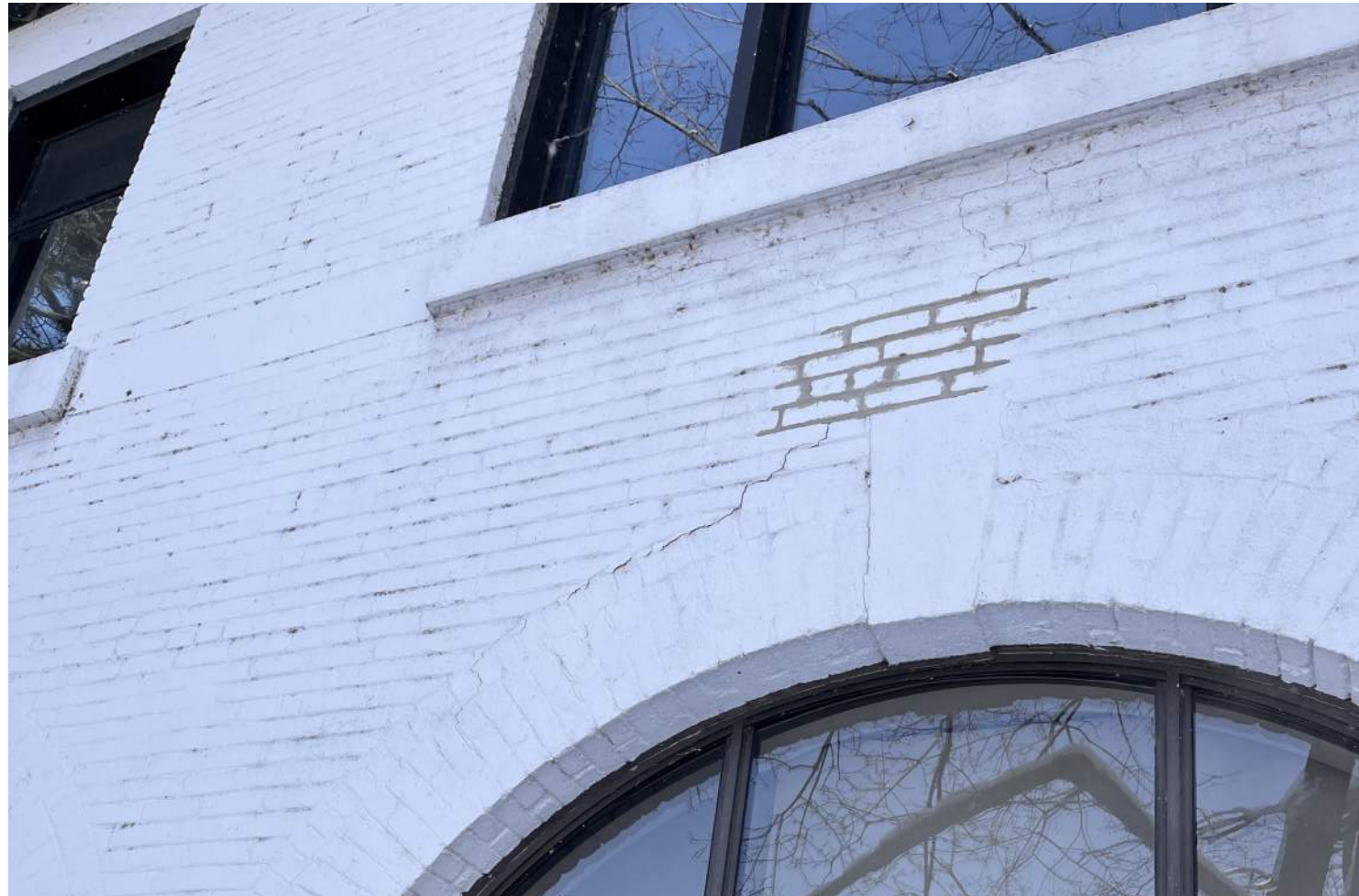
Arche rue Argyle emplacement de la percée exploratoire no 1 du rapport de maçonnerie
