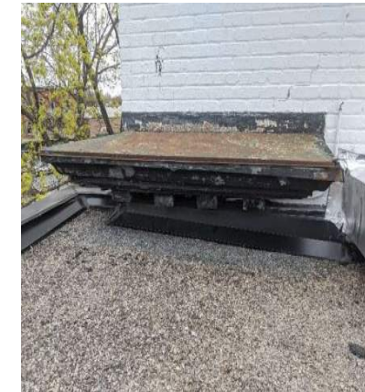
Mise à jour du PDMA 2020 de l'hôtel de Ville, Saint-Lambert, TBMaestro, Fiches d'interventions, p.5
