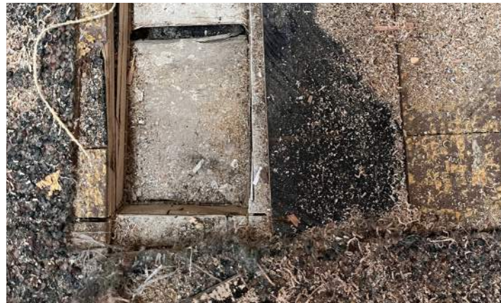
209 Corridor, ouverture exploratoire OE8
