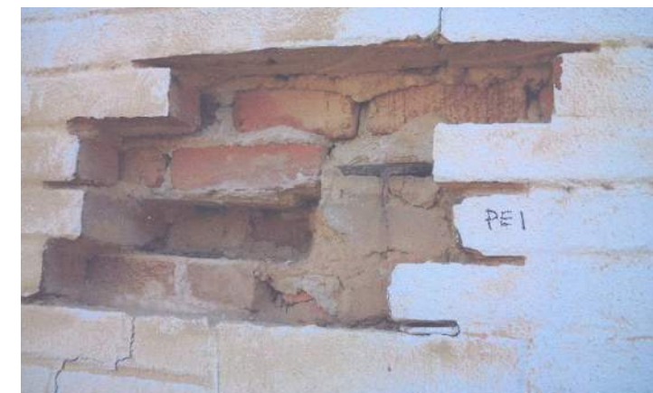
Rapport sommaire des parements de maçonnerie, non daté, photo no 5. Percée exploratoire no 1 (arche rue Argyle) p. 4
