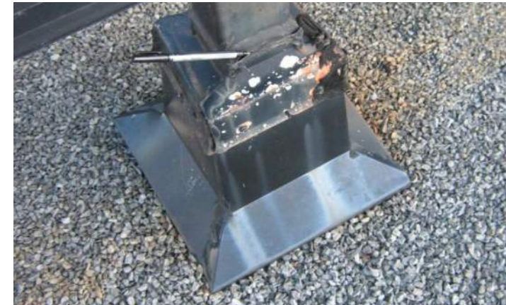
Roof Condition Assessment Report, Ville de St-Lambert, 55 Argyle, Premier Levaque Inc, décembre 2010, p 6
