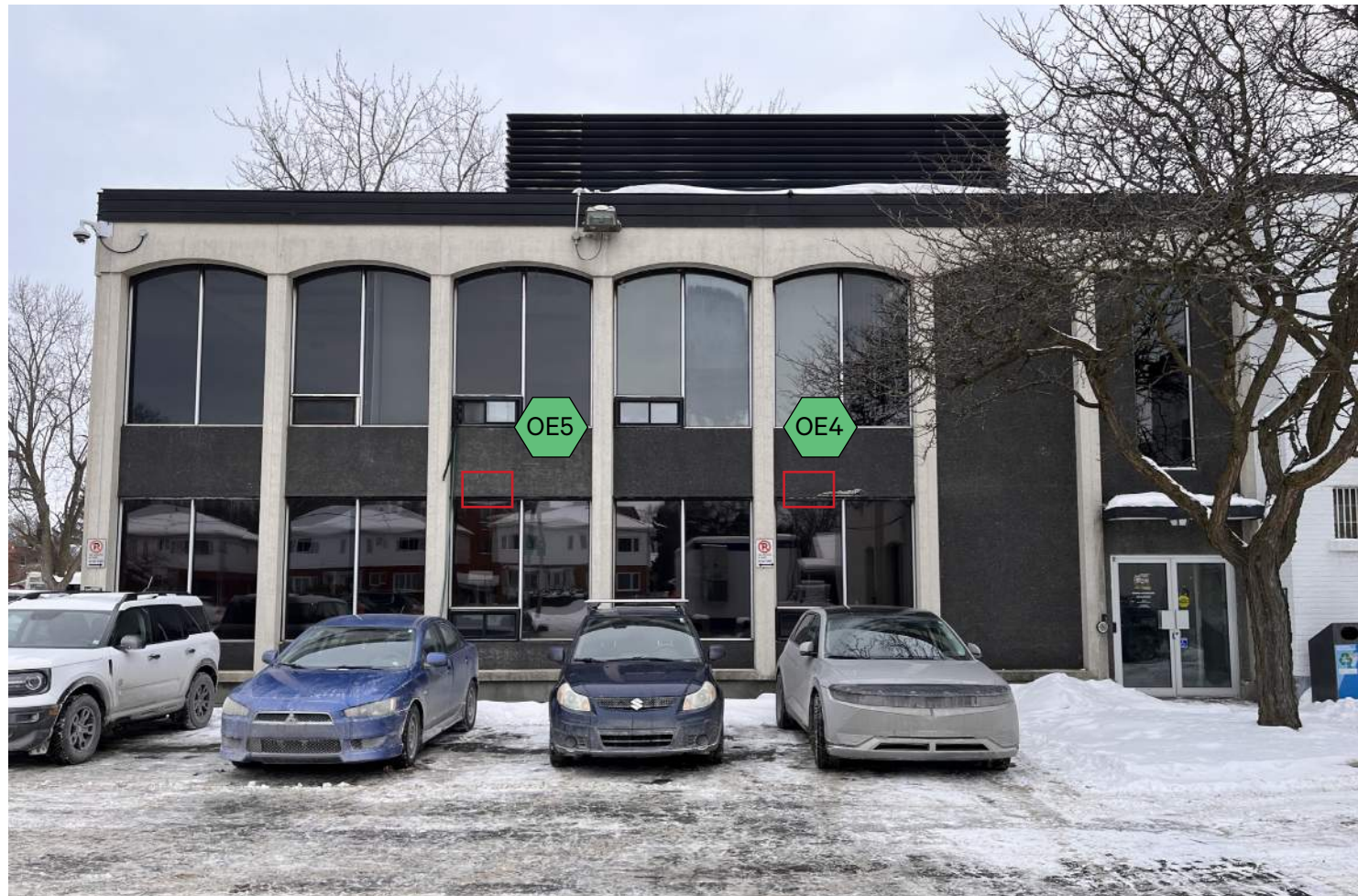
Façade Sud du bâtiment de 1967
