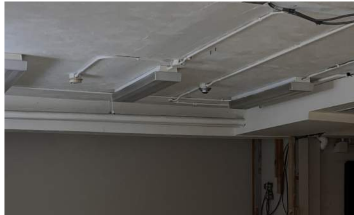
023 Local des pompiers
