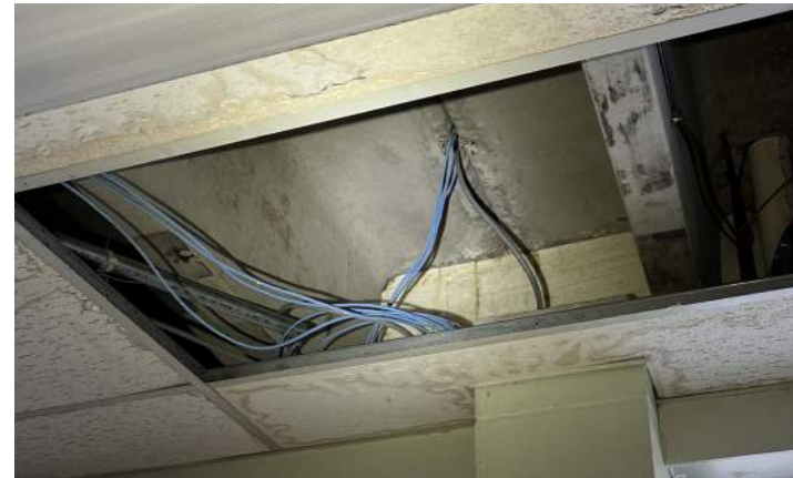
Entre-plafond du RDC
