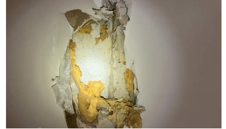
023 Local des pompiers
