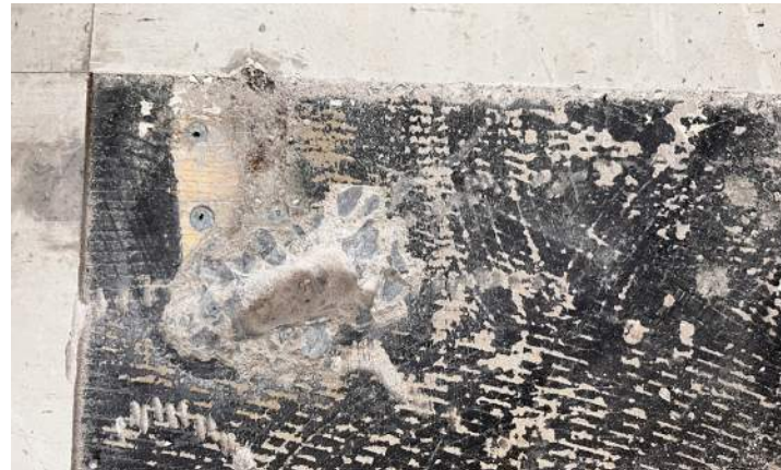
0013 Entrepôt du poste de police, Ouverture exploratoire OE3
