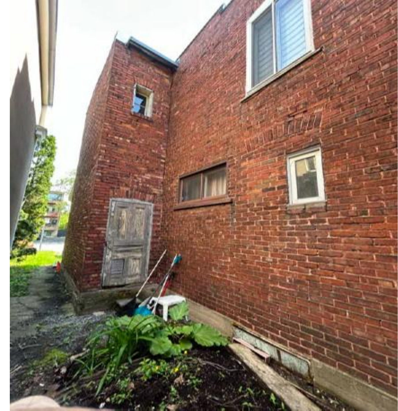
FAÇADE LATÉRALE NORD (côté voisin)
