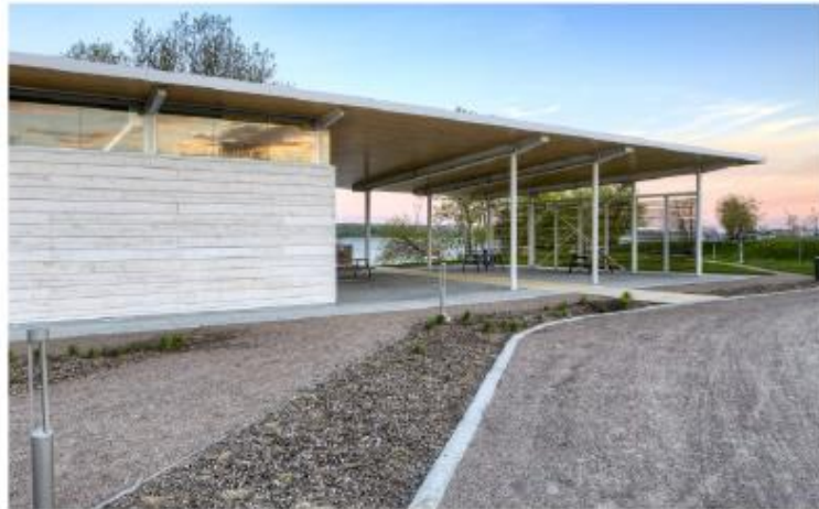
PLATELAGE DE CLT ET STRUCTURE EN ACIER Parc riverain Espace Fillion à l'Ange Gardien (Coarchitecture/François Courville / LGT, Québec)
