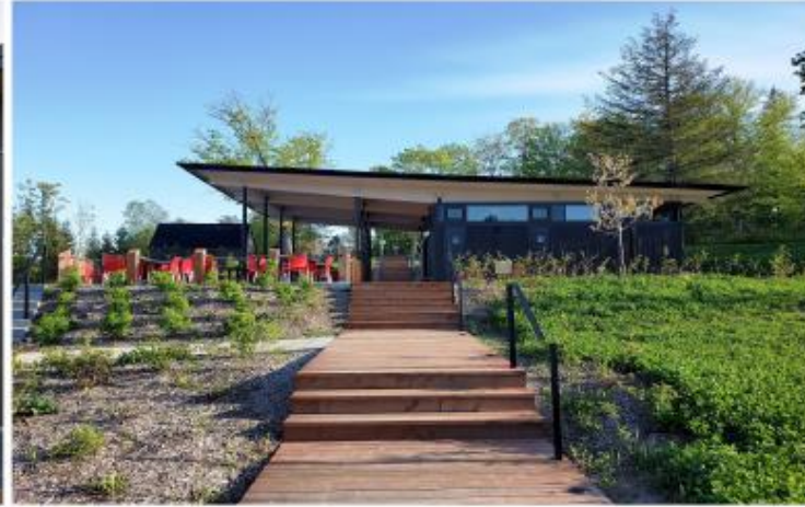
GRANDE TOITURE EN LAMELLÉES-COLLÉES Chalet et pôle nautique Duchesnay (Bourgeois-Lechasseur architectes/Coarchitecture, Québec)
