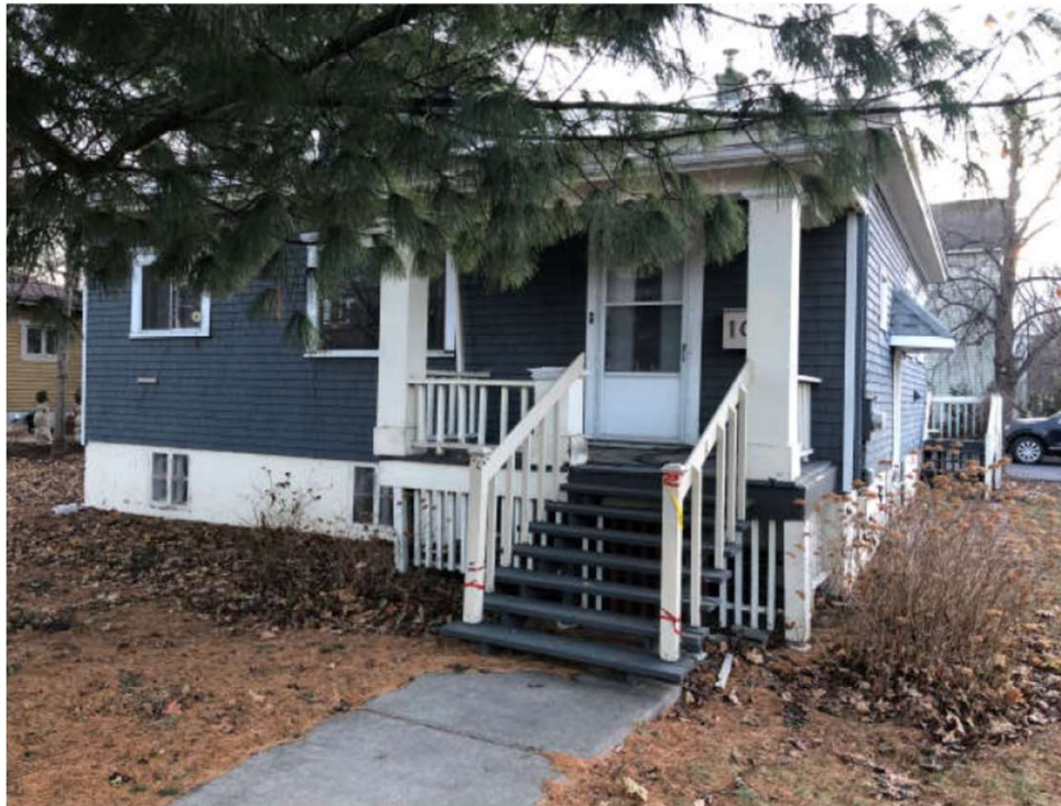
Façade Upper Edison - Existante
