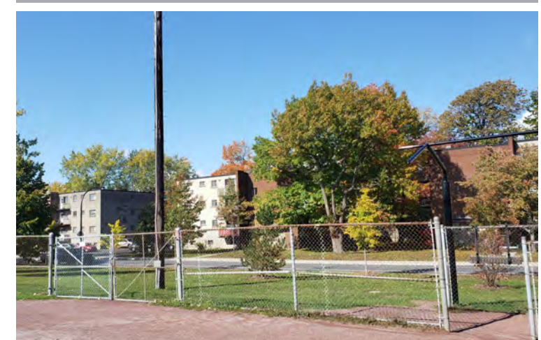
Accès entretien au terrain
