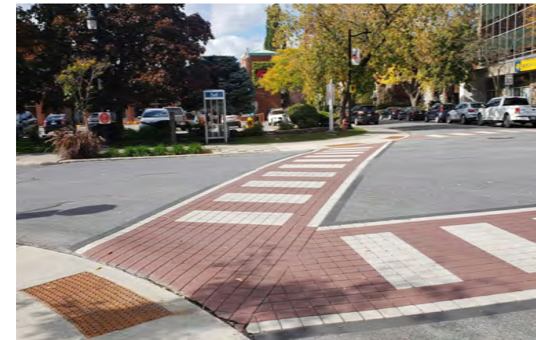
Traverses piétonnes sécurisées
