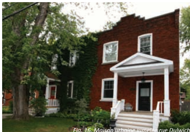
Fig. 16. Maison urbaine jumelée rue Dulwich
